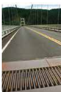
(ب) نمونه‌ای از بست‌های انبساطی
