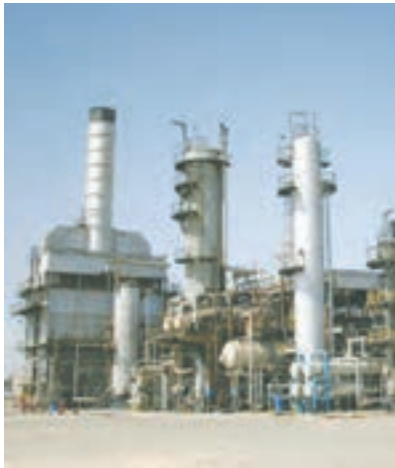
ب) نمای بیرونی برج تقطیر در پالایشگاه
